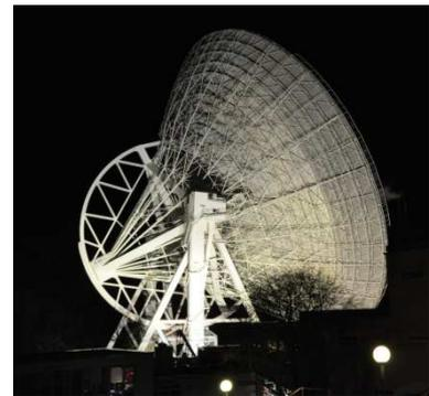
Abb.7: Das schwenkbare 100 m-Radioteleskop in Effelsberg
